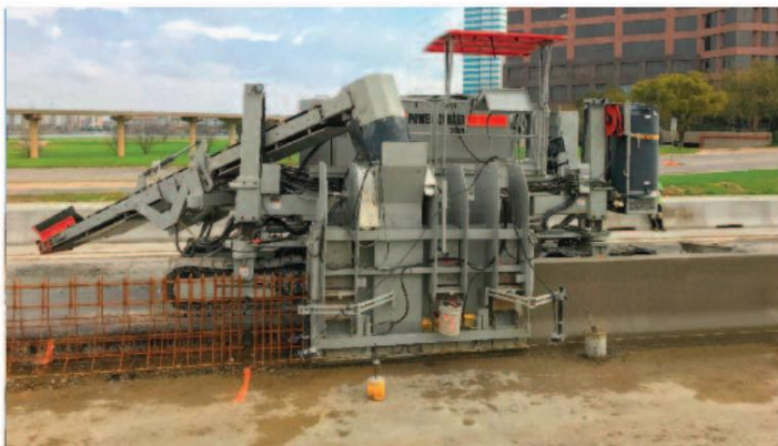
Máquina de bordillo para máquina de encofrado deslizante multiusos Power Curbers 7700
