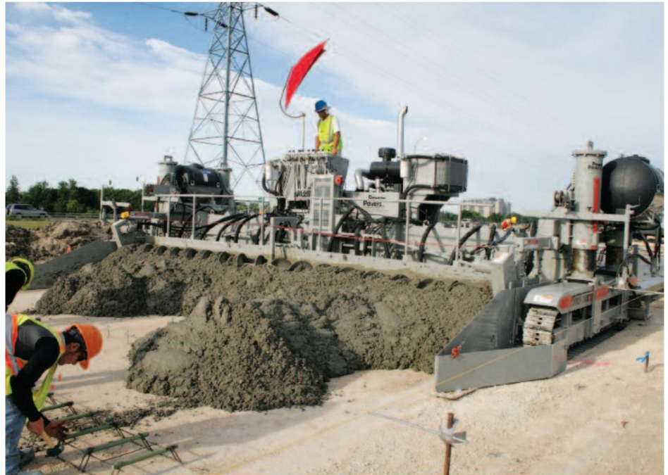
Vista frontal del pavimento SF-2700 sobre cestas de clavijas en Saskatchewan.
