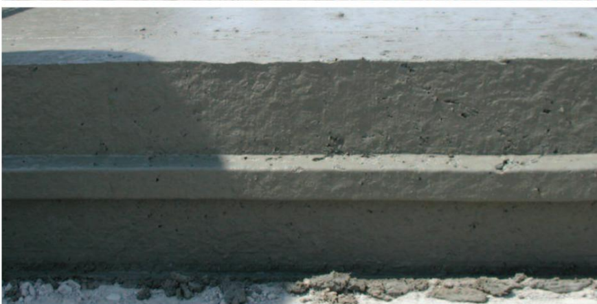
Borde de pavimento con insertador de chavetero opcional (arriba) y bloqueador de chavetero macho opcional (abajo).
