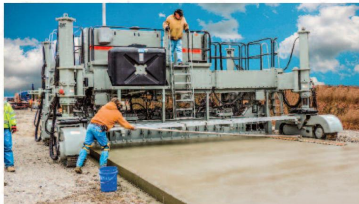
Pavimentadora autopulsada Power Pavers modelo SF-2404, con encofrado deslizante
