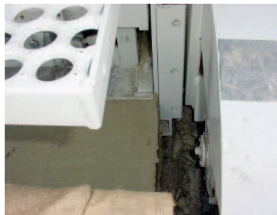
Los encofrados laterales están conectados a las vías.
