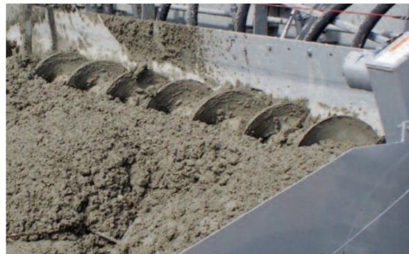
El sinfín de distribución y la placa de enrasado.
