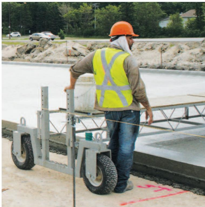
El puente de trabajo opcional WB-2700 sin motor brinda a la tripulación acceso a la losa.
