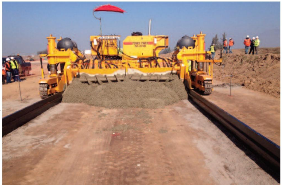
El marco SF-2700 se puede extender para verter sobre formas fijas.
