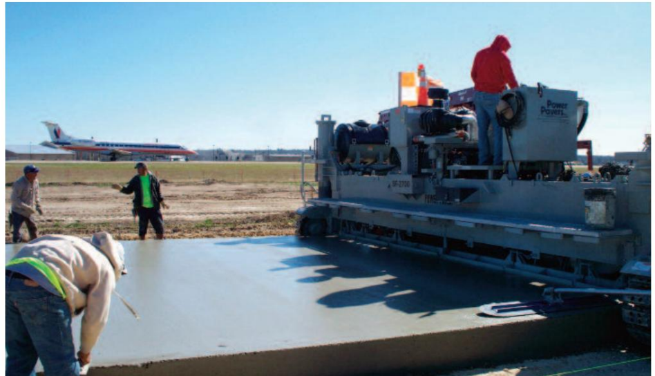
SF-2700 pavimentación de un aeropuerto.
