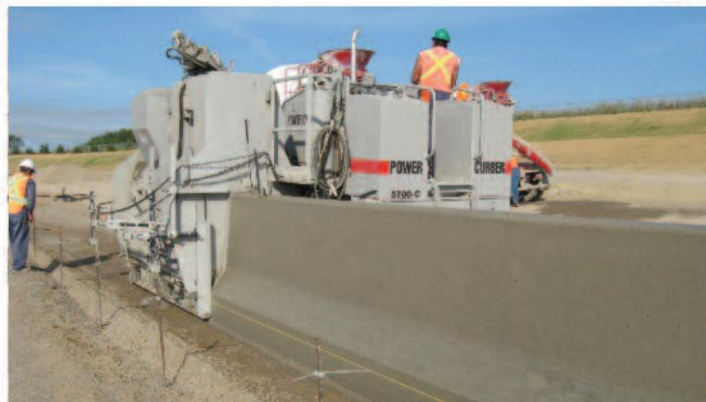
Máquina para bordillos deslizantes Power Curbers 5700-C
