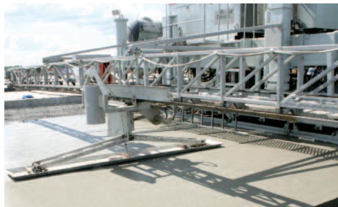
El acabado final opcional cuenta con un flotador mecánico de oscilación.
